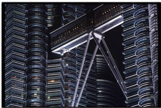
Éclairage du sky bridge. (Photo : JM. Charles)
