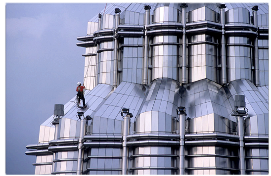
Installation des projecteurs du dôme par les alpinistes. (Photo : JM. Charles)
