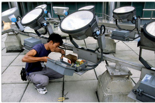
Installation des projecteurs Arena Vision sur la terrasse. (Photo : JM. Charles)
