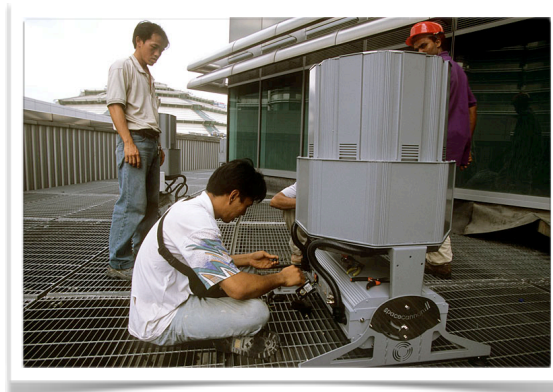
Installation des projecteurs Space Canon Titan sur un des tronçons des tours. (Photo : JM. Charles)
